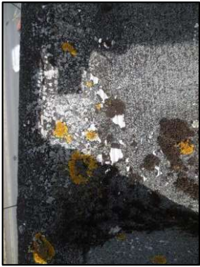
Photo N° 3234 ECH-N°45 -BAT 177-277 Toiture terrasse Etanchéité type "paxalu"
