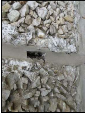
Photo N° 3199 ECH-N°19 --NC-BAT 177-277 pignons Murs Joint de dilatation
