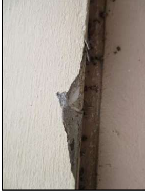
Photo N° 3214 ECH-N°30 - BAT113-157 pignons Murs béton+peinture
