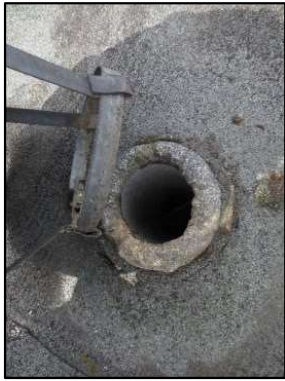
Photo N° 3237 ECH-N°49 AMIANTE CIMENT -BAT 177-277 Toiture terrasse Conduit ventilation (Fibres-ciment)
