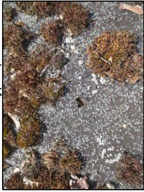
Photo N° 3228 ECH-N° 42 -BAT 177-277 Toiture terrasse Etanchéité bitume
