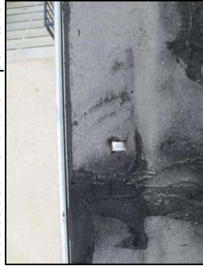
Photo N° 3177 ECH-N°05 -BAT 86-190 pignons Toiture local Revêtement bitumineux
