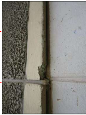
Photo N° 3241 ECH-N°52 - BAT113-157 pignons Murs béton+peinture
