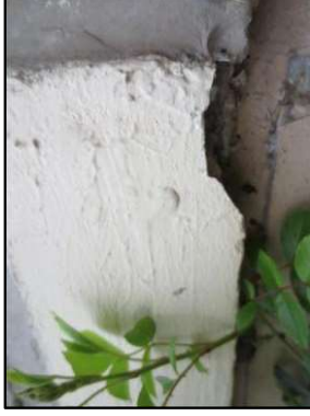
Photo N° 3201 ECH-N°21 -BAT 177-277 pignons Murs béton+peinture
