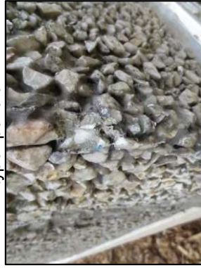
Photo N° 3174 ECH-N°04 -BAT 86-190 pignons Murs béton+pierres
