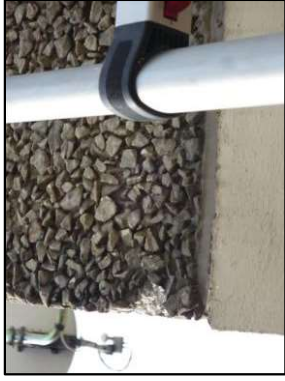
Photo N° 3204 ECH-N°23 -BAT 177-277 pignons Murs Joint de dilatation
