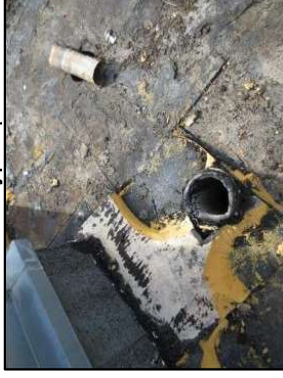
Photo N° 3218 ECH-N°33 - BAT113-157 Toiture terrasse Etanchéité type "paxalu"
