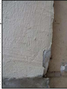
Photo N° 3194 ECH-N°16 -BAT 32-210 pignons Murs béton+peinture
