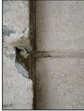
Photo N° 3191 ECH-N°14 -BAT 32-210 pignons Murs béton+pierres
