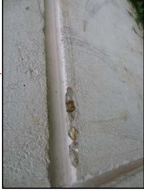
Photo N° 3240 ECH-N°51 - BAT113-157 pignons Murs soubassement béton+peinture
