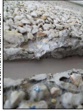
Photo N° 3180 ECH-N°08 -BAT 86-190 pignons Murs béton+pierres
