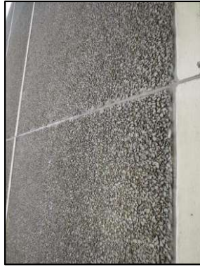
Photo N° 3242 ECH-N°53 - BAT113-157 pignons Murs béton+pierres
