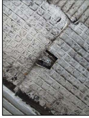
Photo N° 3178 ECH-N°06 -BAT 86-190 pignons Toiture local Etanchéité type "paxalu"
