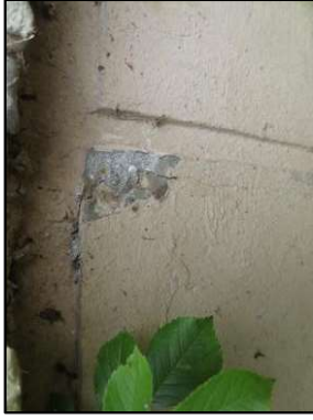
Photo N° 3200 ECH-N°20 -BAT 177-277 pignons Murs soubassement béton+peinture
