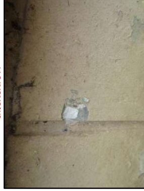
Photo N° 3196 ECH-N°18 -BAT 32-210 pignons Murs soubassement béton+peinture
