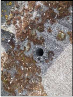
Photo N° 3235 ECH-N°47 AMIANTE CIMENT -BAT 177-277 Toiture terrasse Conduit ventilation (Fibres-ciment)
