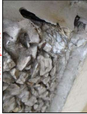
Photo N° 3195 ECH-N°17 -BAT 32-210 pignons Murs béton+pierres
