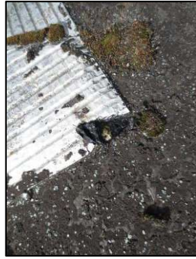
Photo N° 3222 ECH-N° 37 - BAT113-157 Toiture terrasse Etanchéité type "paxalu"
