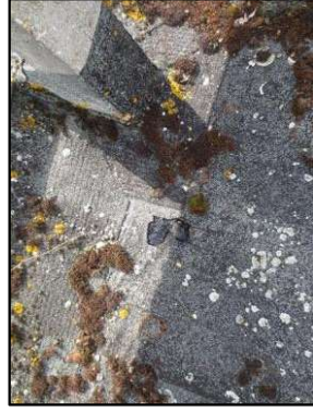
Photo N° 3227 ECH-N° 40 -BAT 177-277 Toiture terrasse Etanchéité bitume
