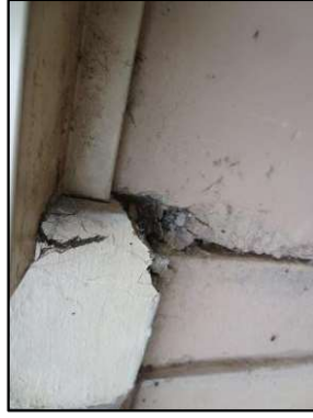
Photo N° 3172 ECH-N°02 -BAT 86-190 pignons Murs soubassement béton+peinture
