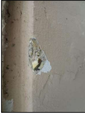
Photo N° 3212 ECH-N°28 - BAT113-157 pignons Murs soubassement béton+peinture
