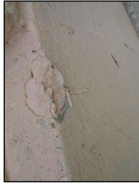
Photo N° 3183 ECH-N°10 -BAT 86-190 pignons Murs soubassement local béton+peinture
