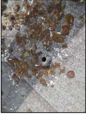
Photo N° 3236 ECH-N°48 AMIANTE CIMENT -BAT 177-277 Toiture terrasse Conduit (Fibres-ciment)
