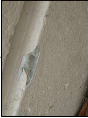
Photo N° 3202 ECH-N°22 -BAT 177-277 pignons Murs béton+pierres
