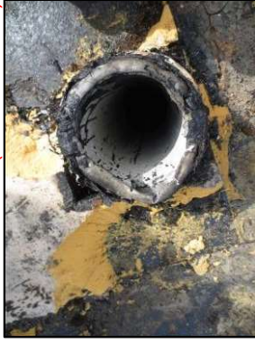
Photo N° 3217 ECH-N°32 AMIANTE CIMENT -BAT113-157 Toiture Conduit (Fibres-ciment)
