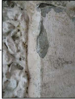
Photo N° 3190 ECH-N°13 -BAT 32-210 pignons Murs soubassement béton+peinture
