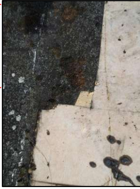
Photo N° 3216 ECH-N°31 AMIANTE CIMENT -BAT113-157 Toiture Conduit (Fibres-ciment)
